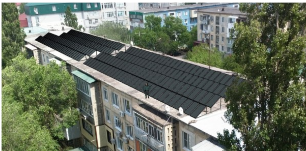
Рис 1. Предлагаемый вариант использования солнечных водонагревательных коллекторов на крыше 5-этажного жилого дома
